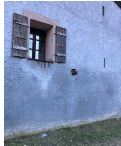
En bas, à droite de la fenêtre, les restes en dalles d'un ancien égouttoir.
