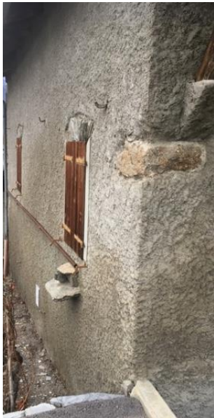
Sous la fenêtre de la cuisine, une ancienne sortie d'eau de vaisselle
