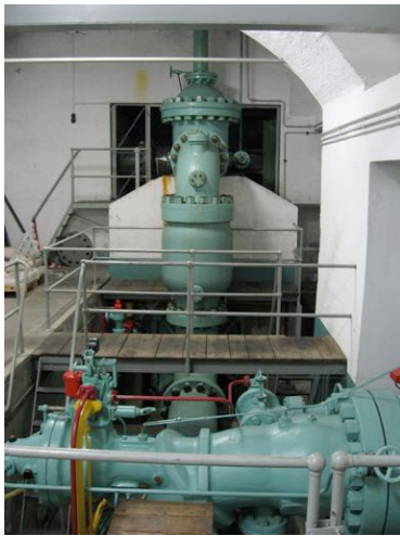
A l'arrière, la vanne automatique et au premier plan une partie de l'injecteur
